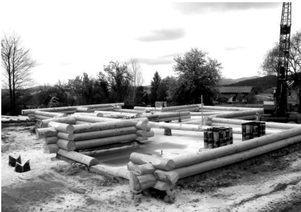
Srub pana Vítovce, zatím ještě ve stavu výstavby.
