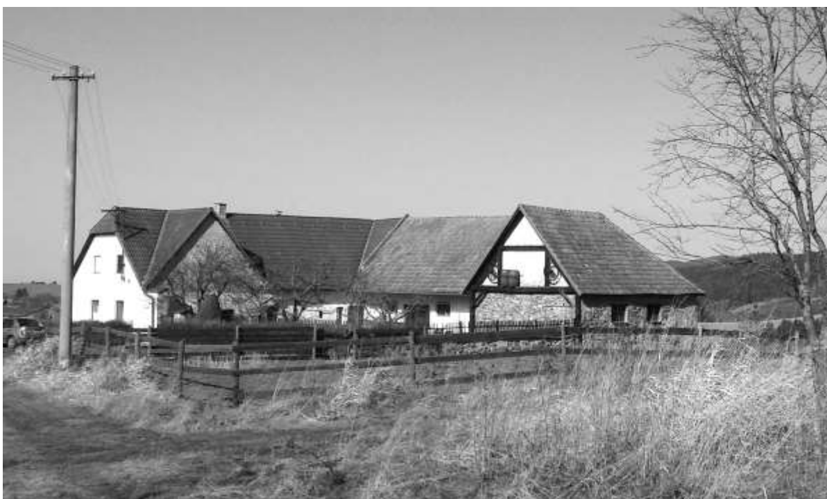
Bývalý Vierkant č. 28 (únor 2016) (Po zbourání rohového předního a pravého bočního traktu stodoly zůstaly již jen oba štíty)
