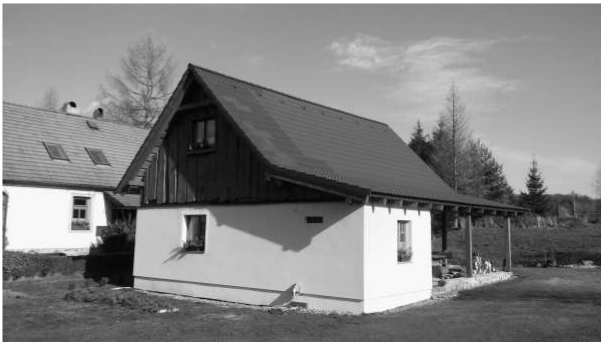
A ještě jeden pohled na bývalou hasičskou zbrojnici...
