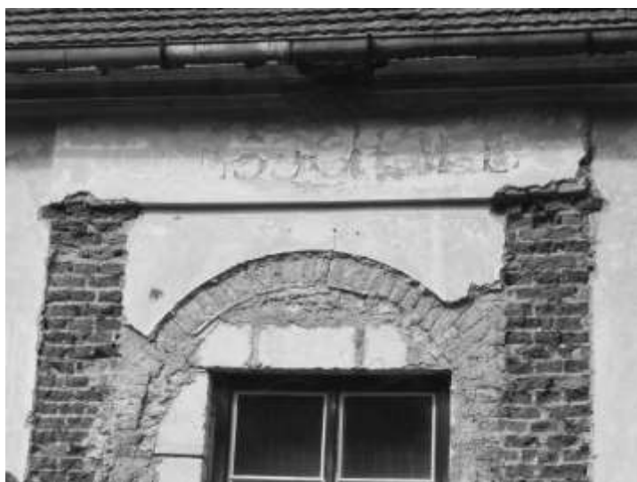
Dosud znatelný nápis „Volksschule“ nad bývalým vchodem do budovy.
