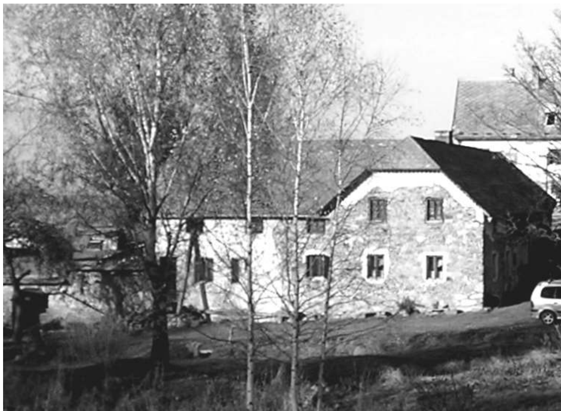
Bývalý statek Pilsů čp. 21 v r. 2006, zatím bez fasády
