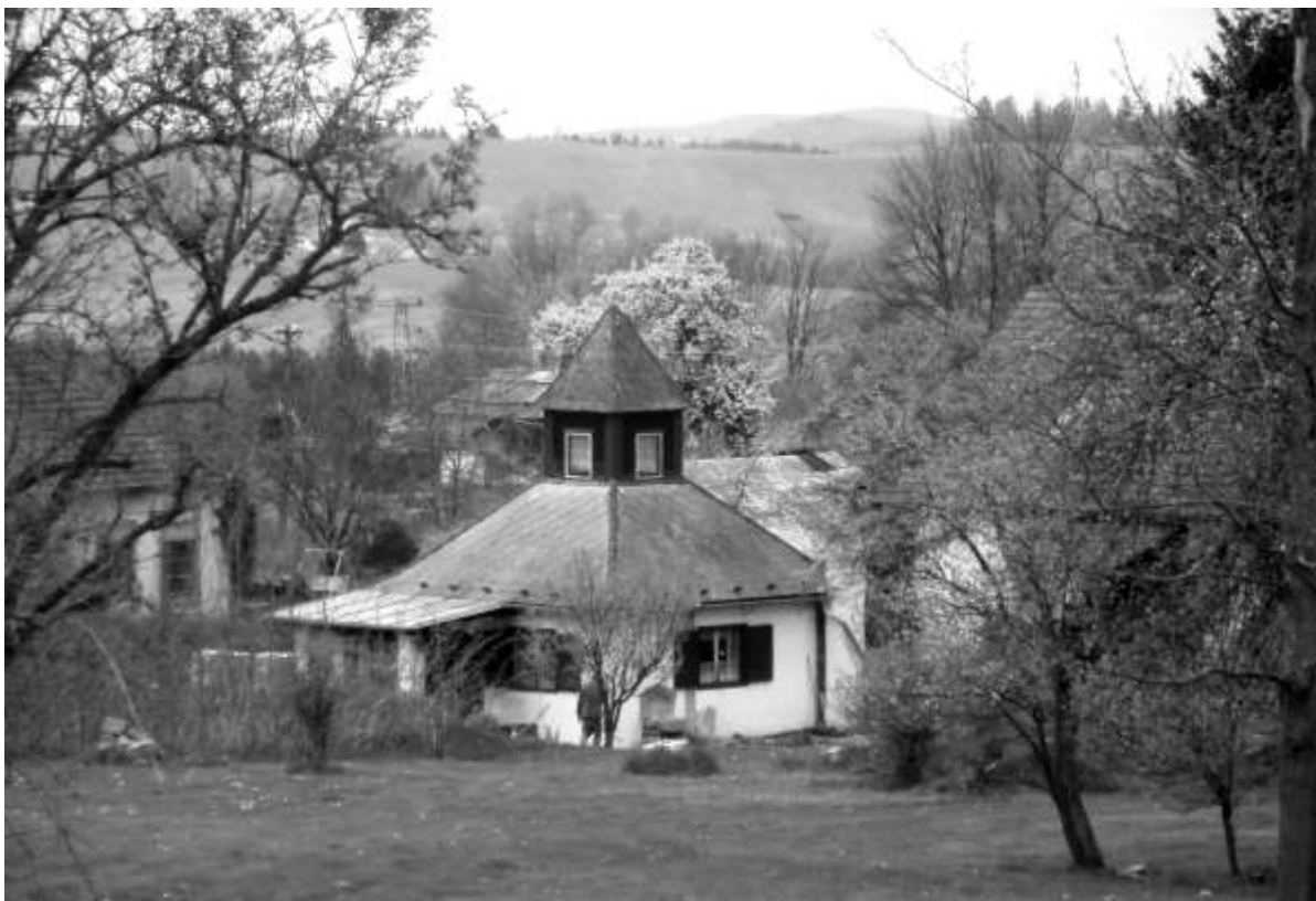
Bývalá hasičská zbrojnice čp. 43 – jaro 2014
