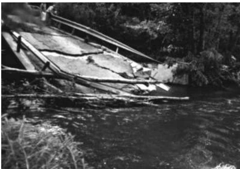
Most přes Pohořský potok těsně po povodni roku 2002...
