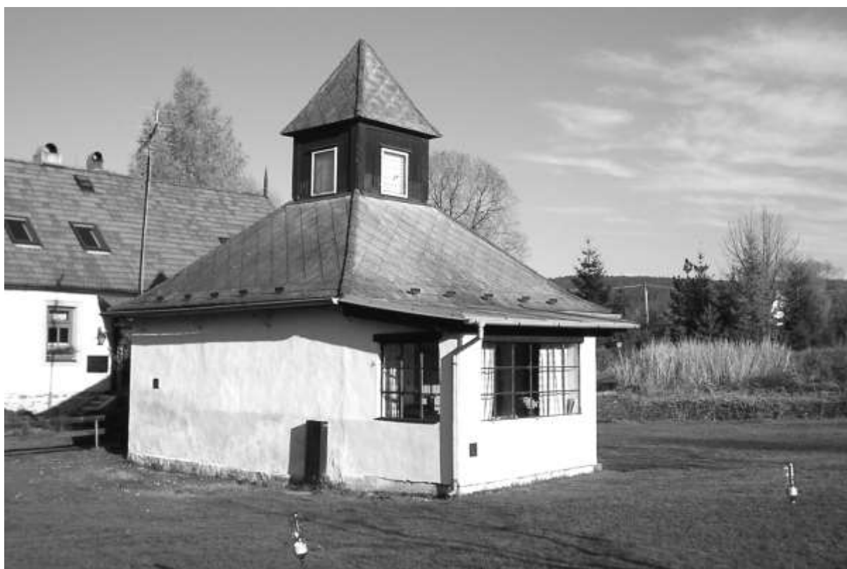
Bývalá hasičská zbrojnice čp. 43, podzim 2006 domek Ernestů
